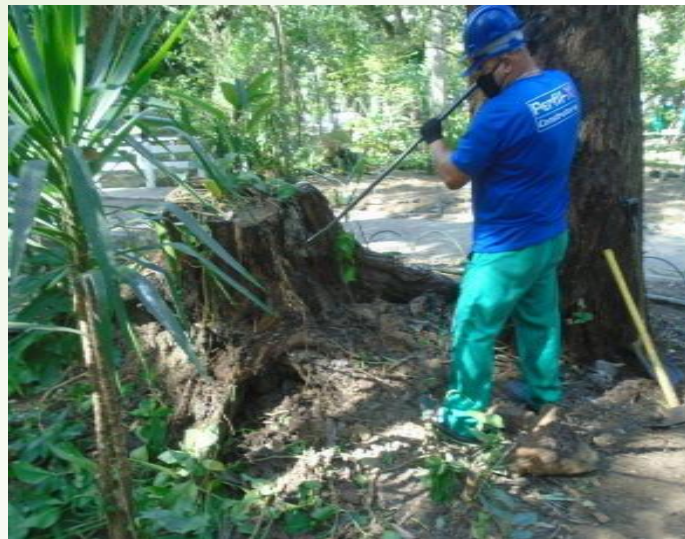
Figura 36 - Operação de destoca
